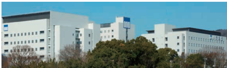
水無瀬第三研究棟
